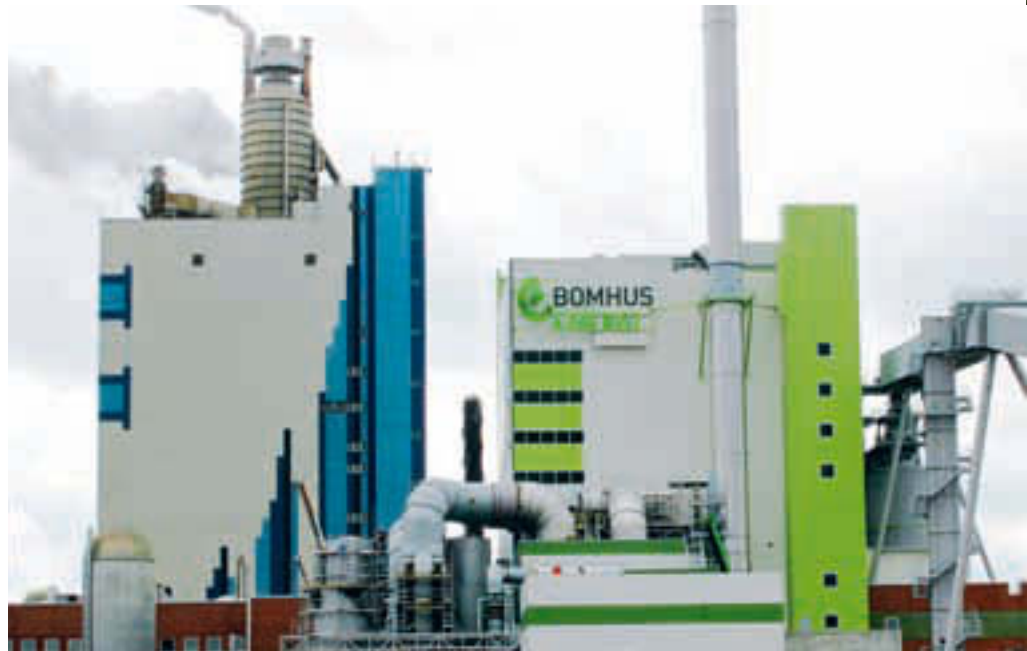
Det nya kraftvärmeverket medför kraftigt reducerade fossila CO 2 -utsläpp.
