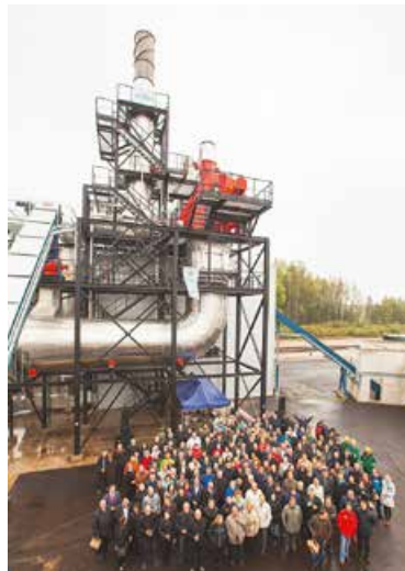
Latgrans fjärde pelletsfabrik invigdes under 2014 i Gulbene, Lettland.
